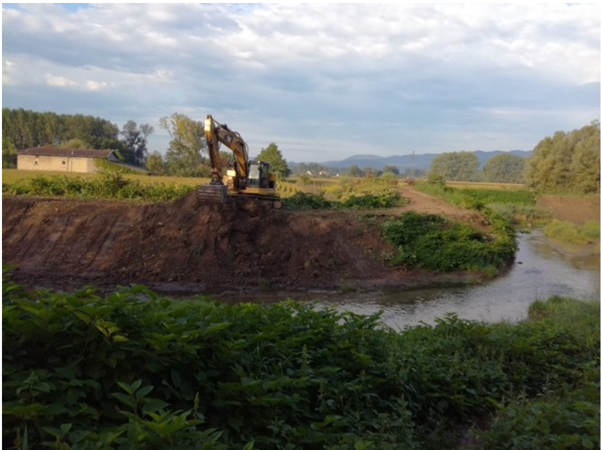
Travaux de berges
